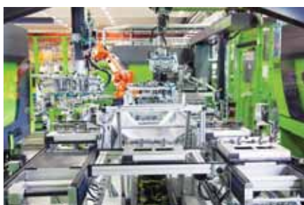
Фото 5. Смонтированная в центре производственной ячейки замкнутая транспортирующая система объединяет три литые машины ENGEL victory 120, на которых изготавливаются рукоятки ножей
